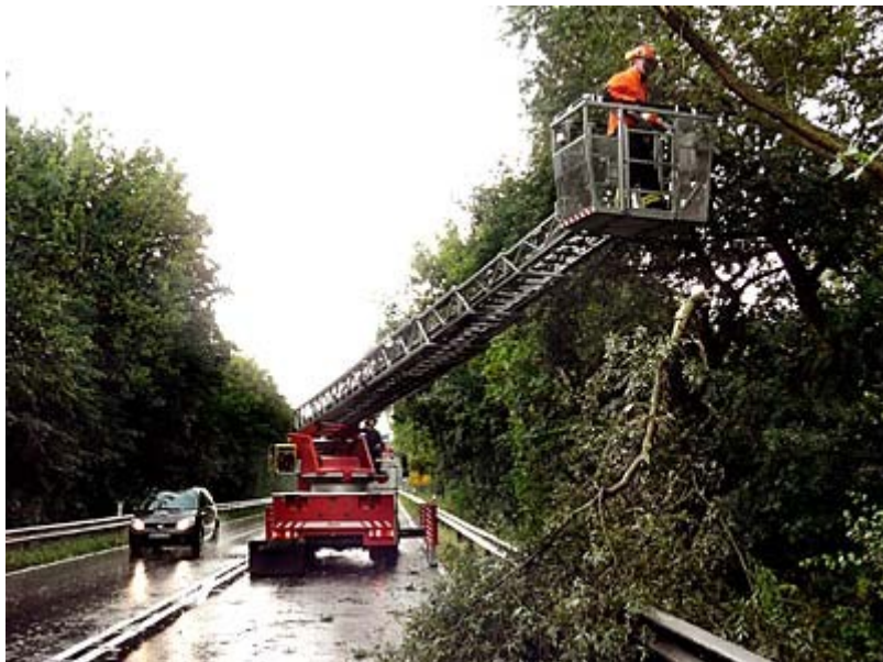
Umgestürzte Bäume sorgen auch auf der B 42 zwischen Bad Honnef und Rheinbreitbach für Behinderungen. Foto: Frank Homann
